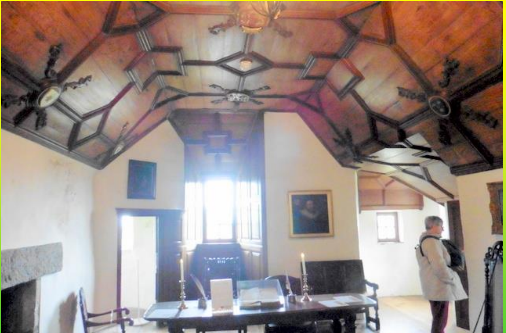
Plafond à caissons de chêne
