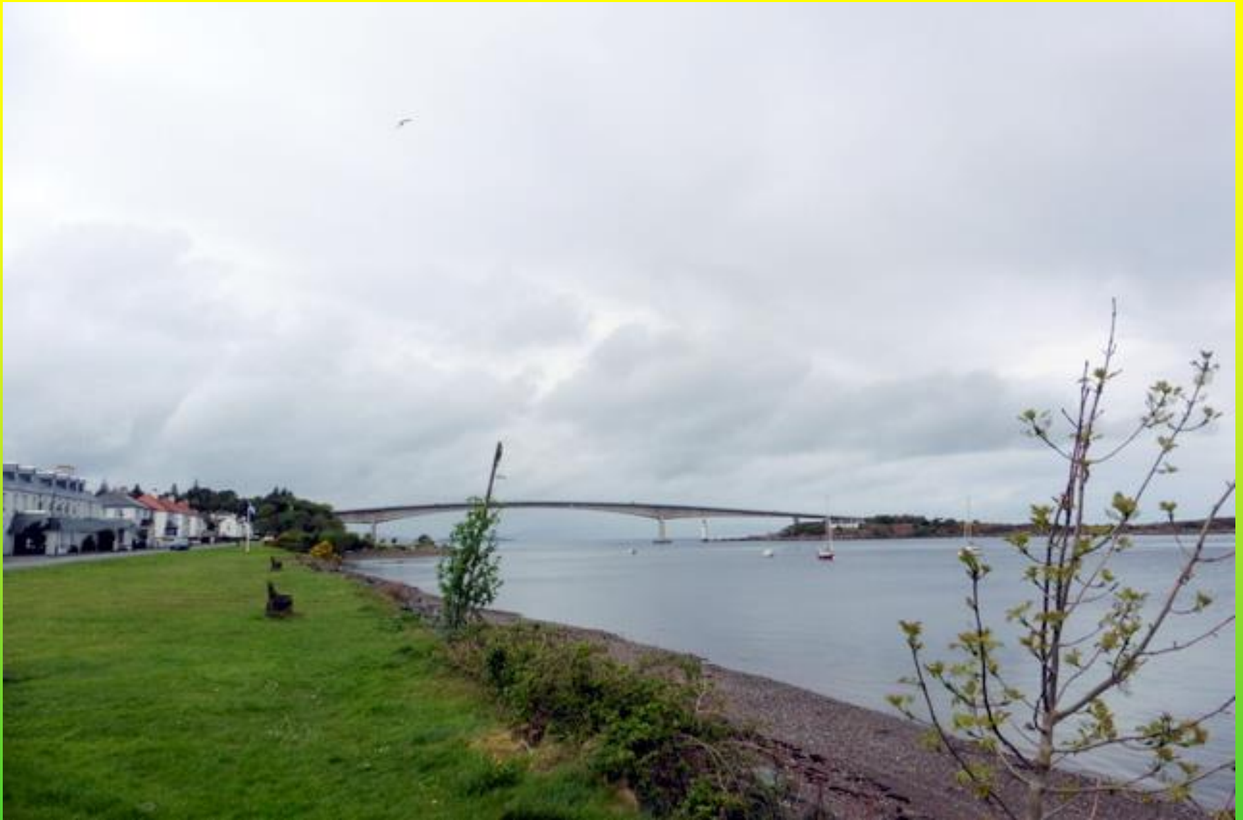
Le pont mesure 430 mètres
