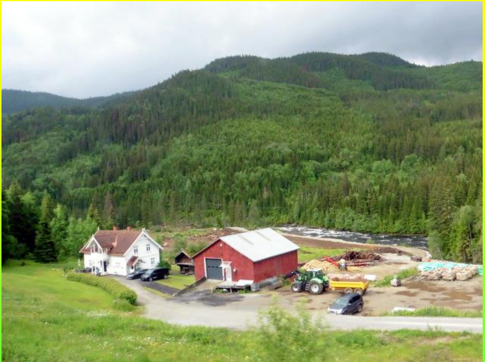
Une ferme : la maison d'habitation en blanc, grange et étable en rouge
